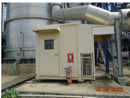
ภาพที่ 2-2 ระบบตรวจวัดคุณภาพอากาศจากปล่องระบายอากาศอย่างต่อเนื่อง (CEMs)
