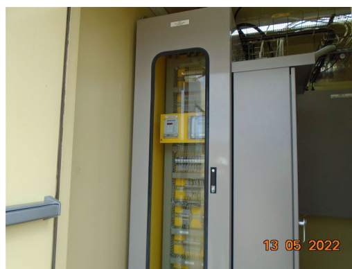
ภาพที่ 2-2 ระบบตรวจวัดคุณภาพอากาศจากปล่องระบายอากาศอย่างต่อเนื่อง (CEMs)
