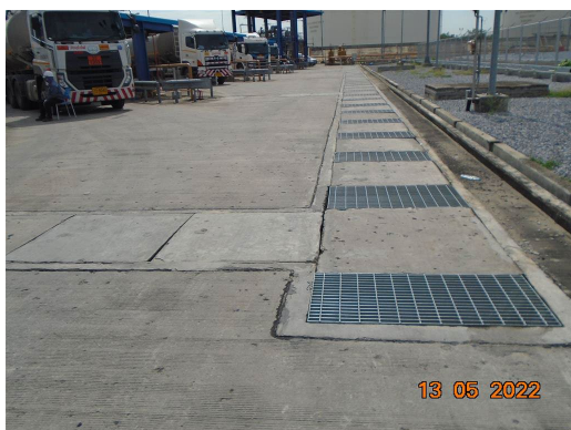
ภาพที่ 2-16 รางรวบรวมน้ำที่อาจปนเปื้อนน้ำมัน
