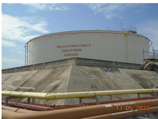
ภาพที่ 2-40 คันล้อย่อมรอบบริเวณถังเก็บน้ำมัน
