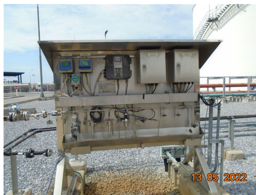
ภาพที่ 2-19 เครื่องตรวจวัดคุณภาพน้ำแบบอัตโนมัติ บริเวณบ่อพักน้ำทิ้ง
