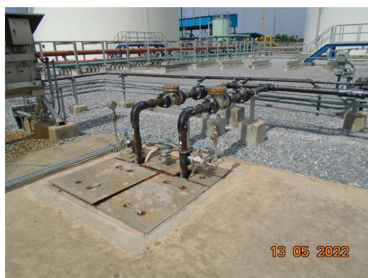
ภาพที่ 2-13 วาล์วควบคุมการเปิด-ปิด บริเวณบ่อตรวจสอบคุณภาพน้ำทิ้ง
